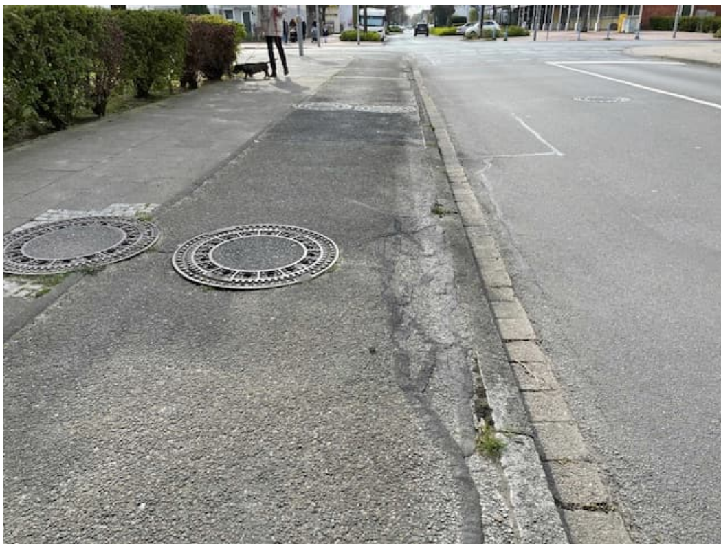
Hindenburgstraße Hs.-Nr. 91, Nebenanlage Aufbruch Asphaltbefestigung
