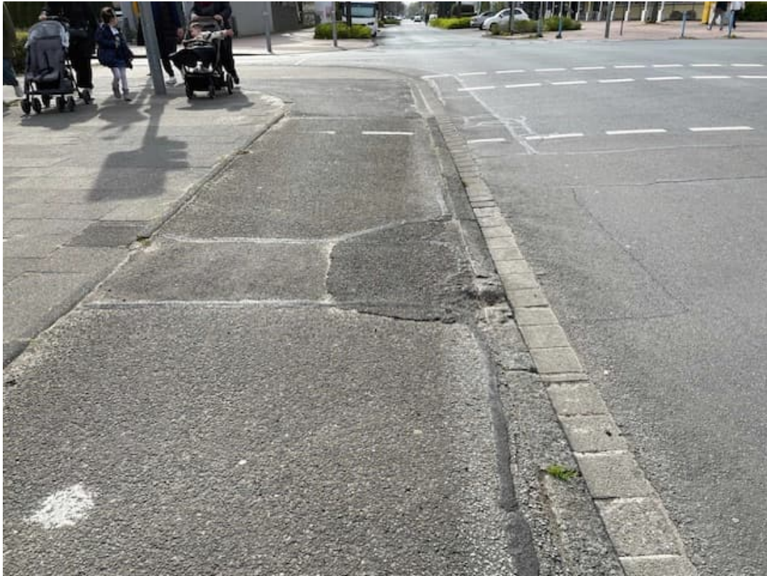
Hindenburgstraße Hs.-Nr. 91, Nebenanlage Aufbruch Asphaltbefestigung Leitungsgraben
